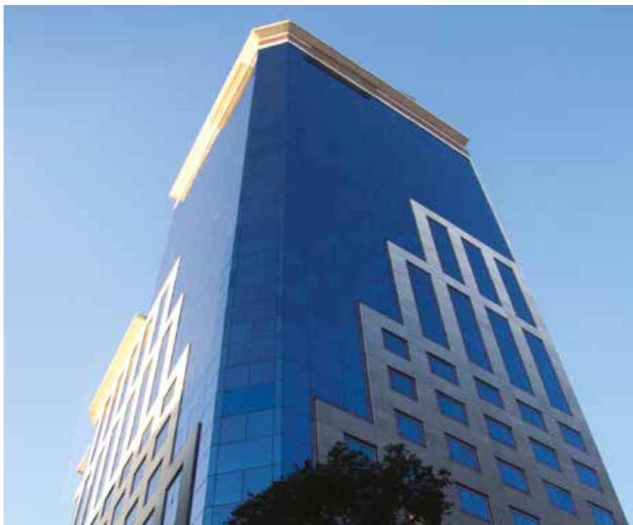
Edifício Candelária Corporate, agraciado com o Selo Procel Edificações em 2016.
